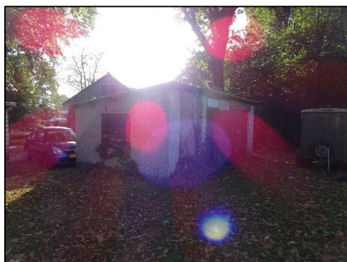
Aanzicht westelijke zijde te slopen schuur
