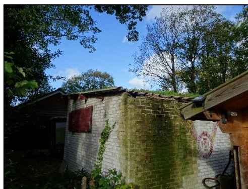
Aanzicht oostelijke zijde te slopen schuur
